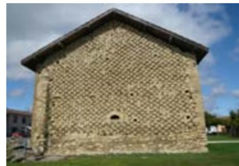
Des fondations à 1,30m et un soubassement en galets et pierres calcaires monté à la chaux
